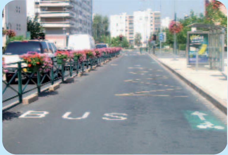
! Pour le confort et la sécurité des cyclistes, le couloir bus-vélos devra être élargi à au moins 4,3 mètres (même en configuration « ouverte ») si la voie est en montée, en cas de forte fréquence de bus ou de vélos (itinéraire structurant).
